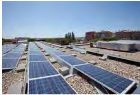
Figura 3. Planta de producción de energía fotovoltaica.
